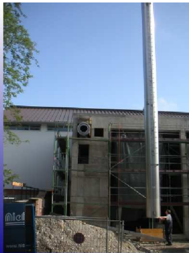
Montage des Aussenkamins
