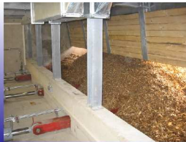
aktives Brennstofflager (250 m 3 ) mit Hydraulik-Schubböden
