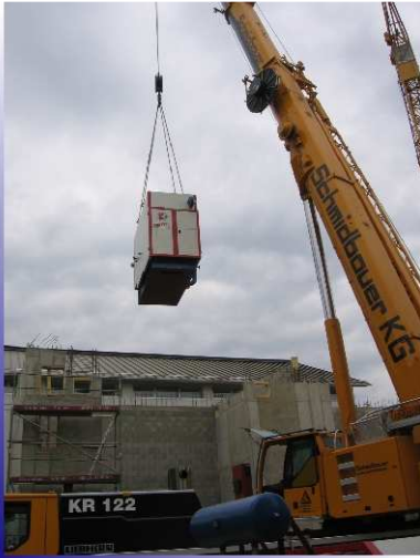
Montage des Heizkessels
