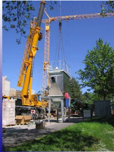
Montage des Elektrofilters
