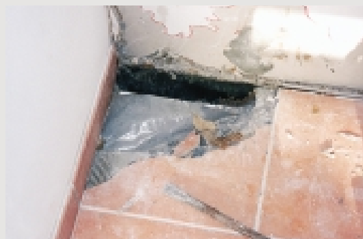
Bild 1.2 • Aufsteigende Bodenfeuchtigkeit
