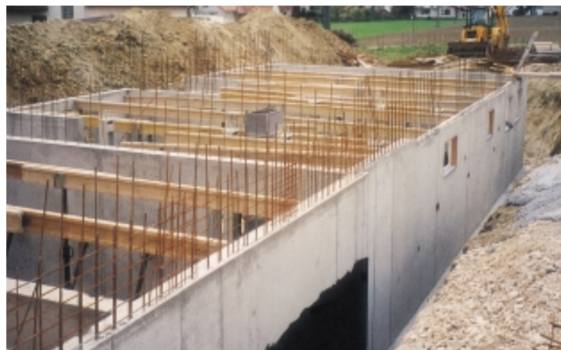
Bild 4 • Erstellung des Kellergeschosses
