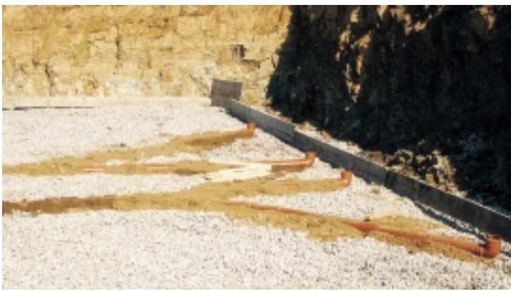
Bild 2 • Grundleitungsverlegung
