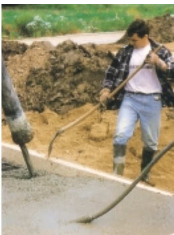
Bild 3 • Betonieren der Bodenplatte
